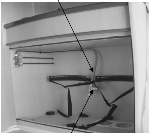
Anschlussschlauch mit Druckminderer
